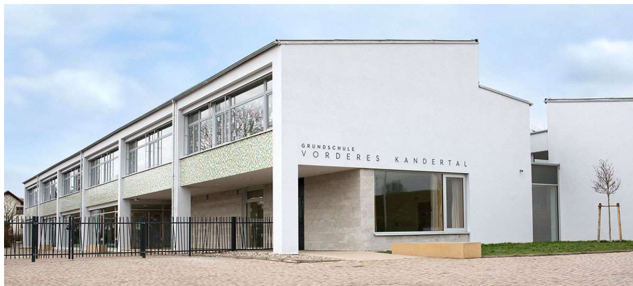
Abb. 25: Ansicht Grundschule GVV Vorderes Kandertal; 2016
